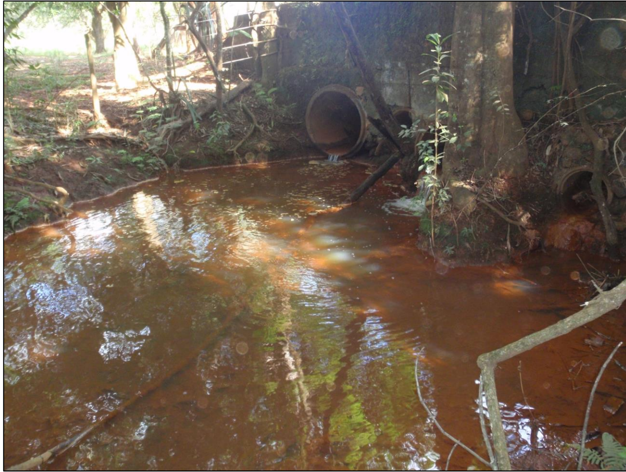
Cor castanho-avermelhada na descarga das tubagens de drenagem da barragem após tratamento de água. Mina Morro do Ouro, Paracatu, Minas Gerais, Brasil
