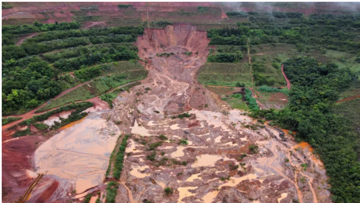
Figura 2. Uma instalação de armazenamento de rejeitados filtrados de 48 metros de altura colapsou na mina de minério de ferro de Pau Branco, no Brasil, em 8 de janeiro de 2022. Foto de Angelo (2022).
